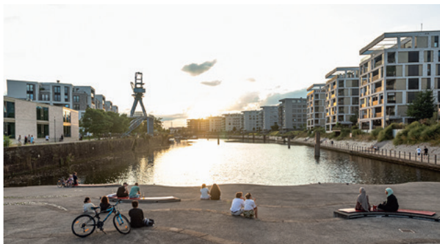
Abb.2: Blick ins Hafenviertel. Hafenschule, Gutsche Park und Blauer Kran (links), Hafentreppe und Hafenbecken (mittig), Vordere Reihe der Wohn- und Gewerbebebauung der Hafeninsel (rechts) © Jonathan Kuhlmann
