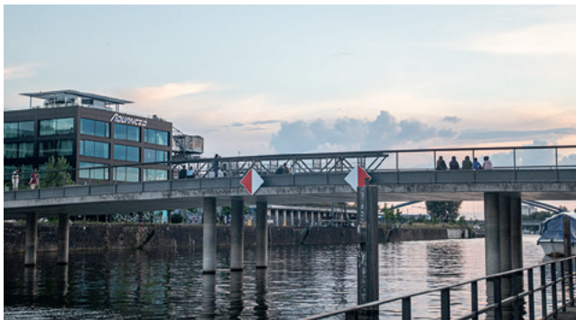
Abb. 6: Nördliche Seite des Hafenplatzes. Eine Person sitzt auf einem Element des defekten Wasserspiels am Hafenplatz. © Jonathan Kuhlmann
